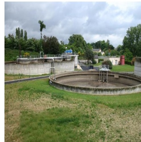
Photo 1 - Bassin de décantation (STEP de Pacé - Ille-et-Vilaine)
